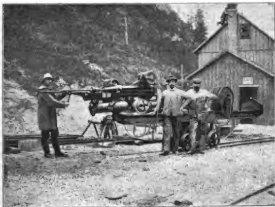
Fig. 5. Elektrische Bohrmaschine mit Spannsäule und Leitungskabel auf dem Bohrwagen.
